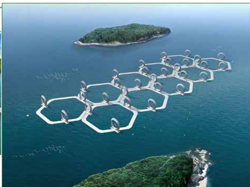
次世代カーボンファイバーを用いた超大型風車の構想
