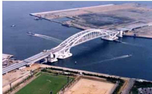
夢舞大橋; 橋脚部が浮体、回転させて船舶通行可能
