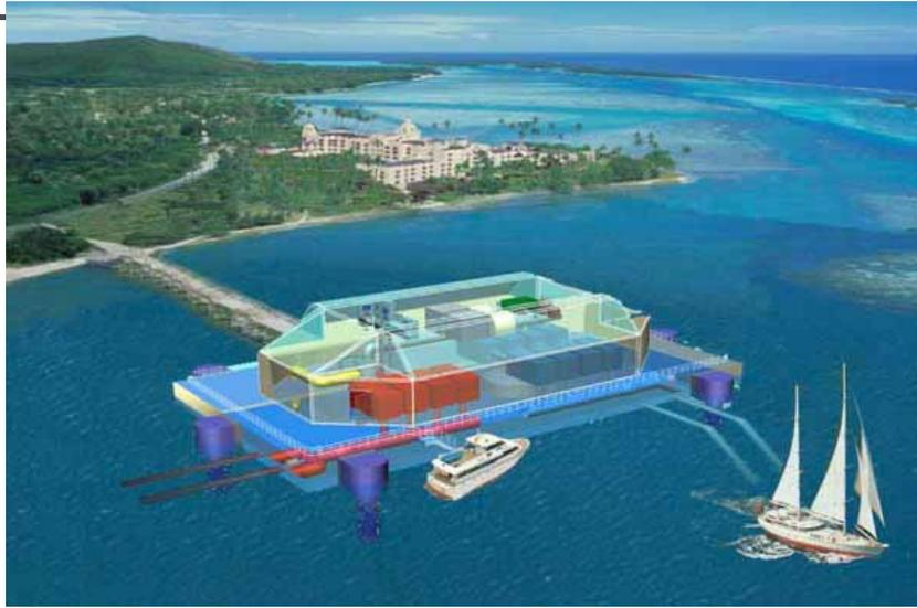
OTEC半潜水型プラント(浮体)のイメージ
