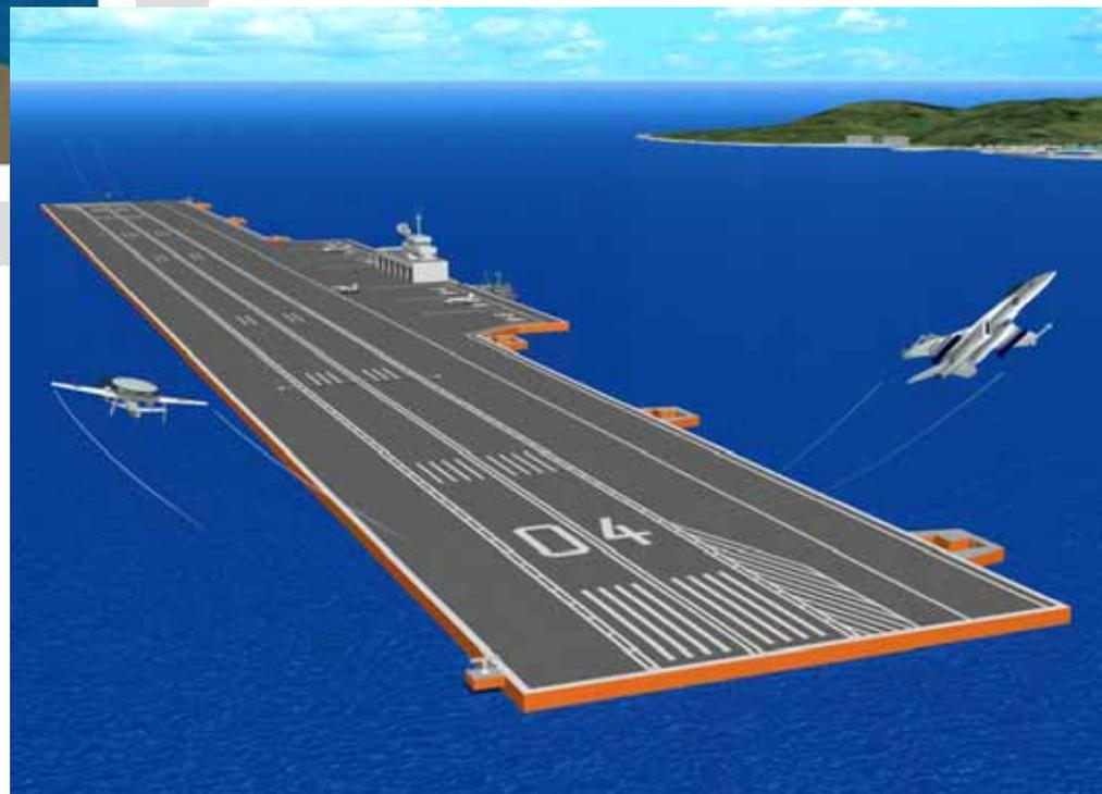
艦載機訓練飛行場浮体式滑走路
