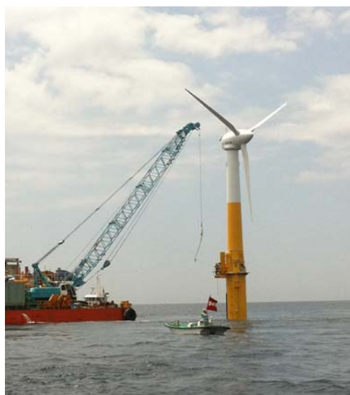
図 2-1-10 浮体式洋上風力発電施設の建て起こし（左）と設置（長崎県・五島市）
