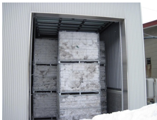
写真 1.3-4 苫前漁港（北海道）での雪氷熱利用例（雪で冷やした空気を利用した空調システム）
