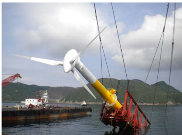
図 2-1-10 浮体式洋上風力発電施設の建て起こし（左）と設置（長崎県・五島市）
