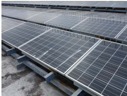
写真 2.4-10 防鳥用剣山（突起物）の設置事例
