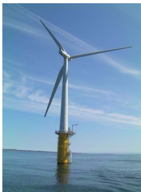
図 2-1-11 浮体式洋上風力発電施設「Hywind」
