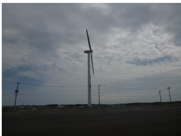
写真 3. 2-3 風力発電施設
