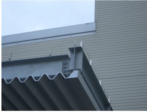
写真 2.4-9 荷捌き施設における防鳥ワイヤーの設置事例
