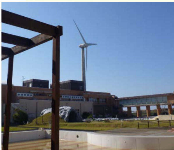
写真 3.2-4 道の駅と風力発電施設
