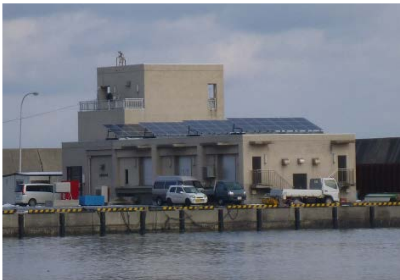
写真 3.1-1 活魚蓄養施設と、屋上に設置された太陽光発電施設
