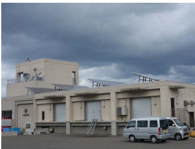
写真 2.4-2 白糠漁港（陸屋根の例） 活魚蓄養施設屋上に設置（10kW）
