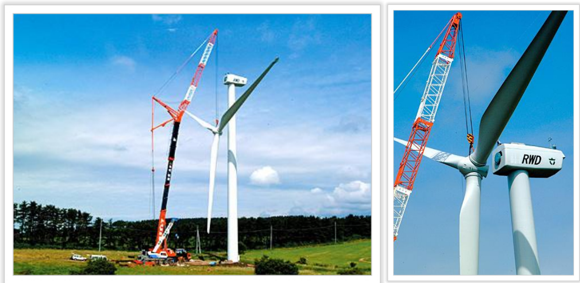
写真 2.5-2 風車のロータ取付状況
