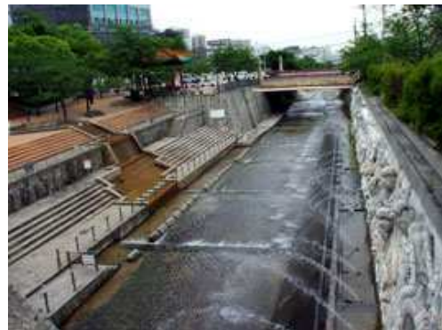
図 1-20：生田川公園 （出典：神戸市建設局 HP）
