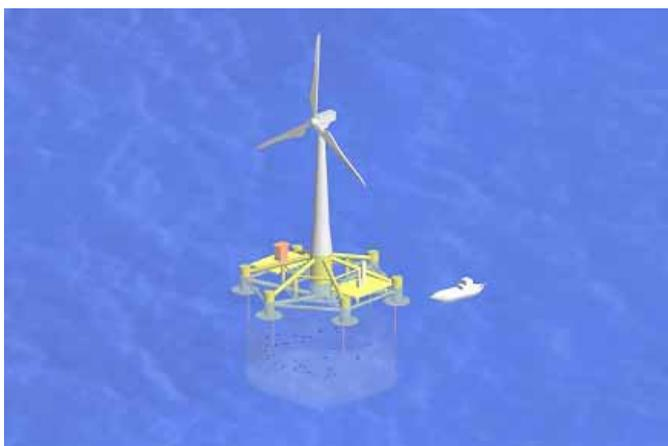
図10 セミサブ式浮体の下部空間に養殖いけすを設置
